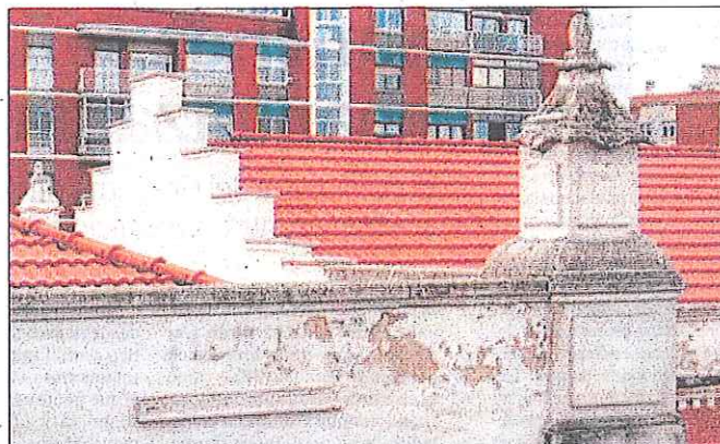
La obra arreglará los desprendimientos en las fachadas de la Consejería de Sanidad. EM
